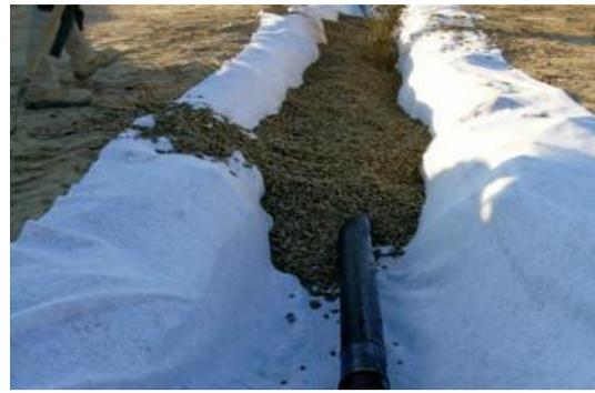
**Imágenes 20 y 21:** Balsa de almacenamiento y tubería de sistema de drenaje.
