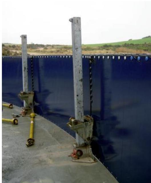
**Imagen 19:** Instalación de paneles de acero vitrificado.
