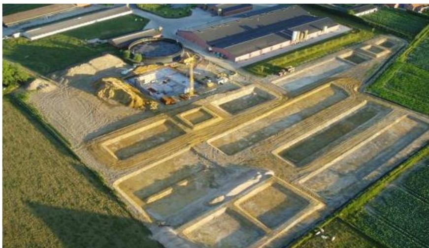
Imagen 27: Construcción de humedales en la planta de West-Vlaanderen
