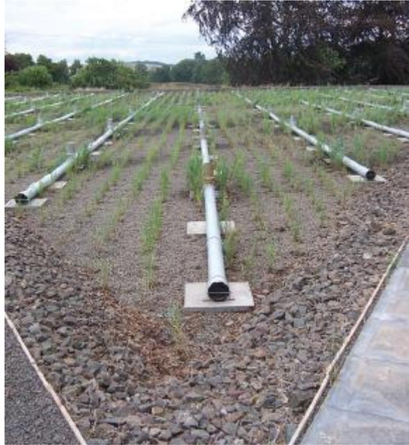
**Imagen 25:** Humedal artificial de flujo subsuperficial vertical
