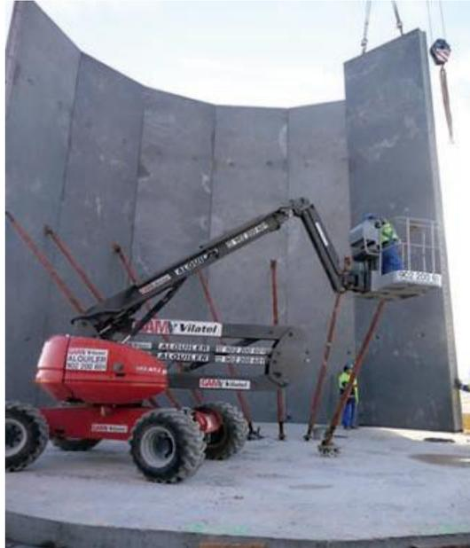
**Imagen 18:** Montaje de bloques de hormigón prefabricados.
