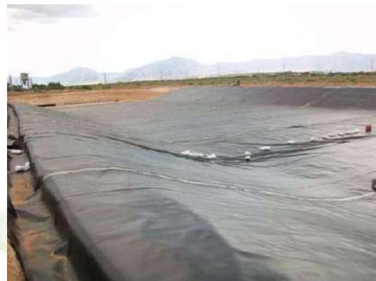
Imágenes 24 y 25: Cobertura de fosa de purines con bolas de arcilla; Cobertura con lámina impermeable.
