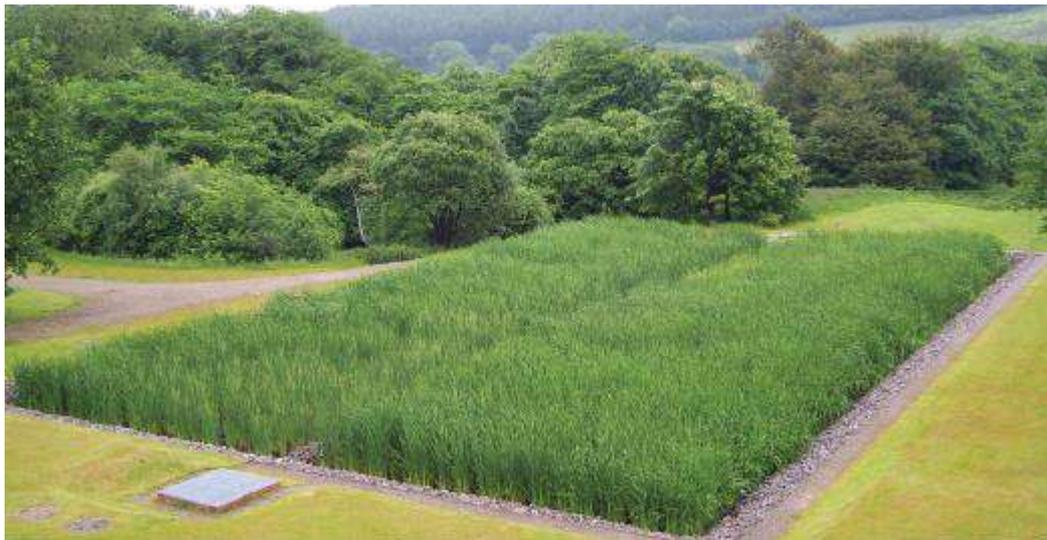
*Imagen 24: Humedal artificial de flujo subsuperficial horizontal*
