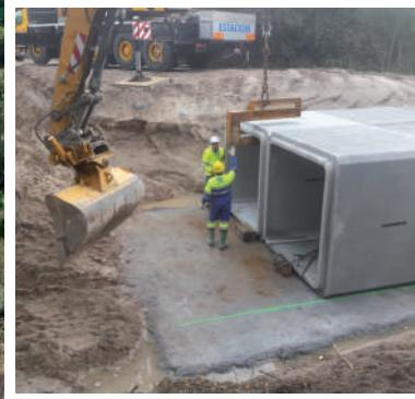
Se realizó la conexión hidráulica parcial de las dos charcas a través de dos obras de paso (de entrada y salida), que conectaron el cauce con cada una de las dos charcas afectadas y una tercera que comunica las dos charcas entre sí garantizando la continuidad del flujo de agua
