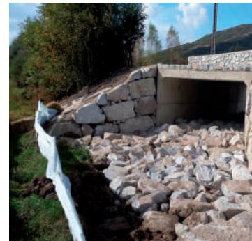
Se construyeron dos aliviaderos, uno de entrada y otro de salida, para que cuando el río alcanza un determinado caudal, el agua discurre por el antiguo meandro del río
