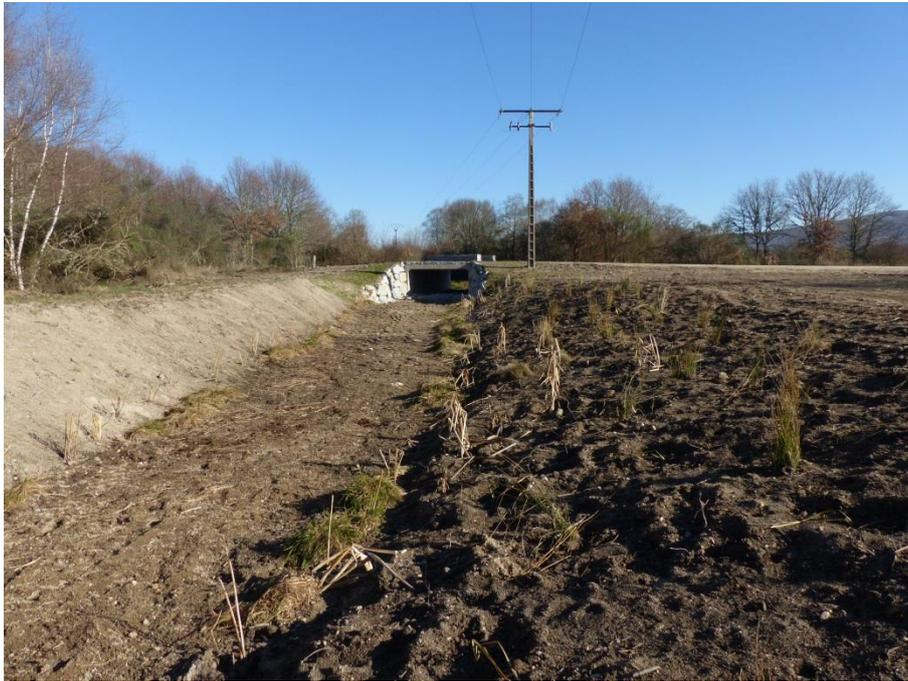
Figura 3.5. Zona inicial del cauce del meandro recuperado donde se puede observar un ancho de cauce más ancho.
