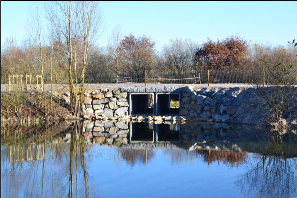
Figura 4.12. Salida de flujos instalada en una de las areneras.
