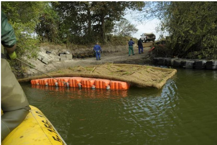
Foto-Introducción de un módulo en la balsa en la zona utilizada como embarcadero.
