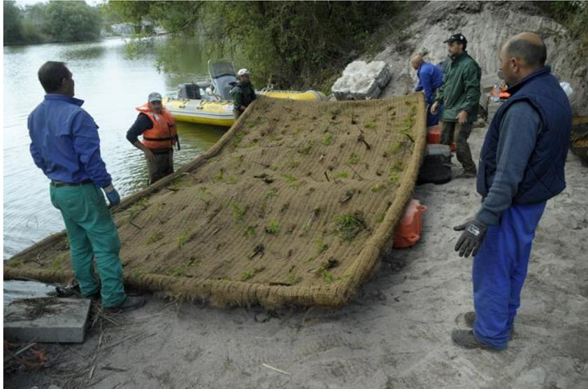
Foto-Colocación de un módulo sobre el soporte utilizado para su traslado dentro de la balsa.
