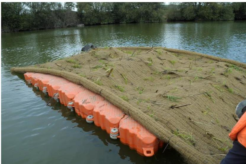
Foto-Colocación de un módulo de una isla en su disposición final.
